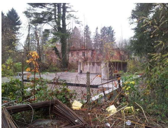
Stanje na terenu v novembru 2012: odstranjena cisterna, pogled z južne strani
